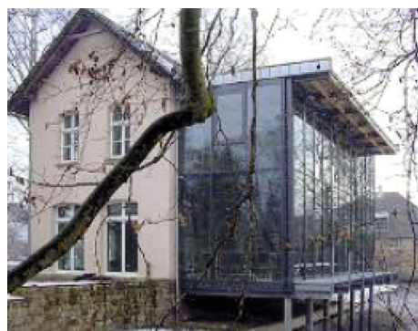
Saniertes Kavaliershau des Ritterguts Meinbrexen
